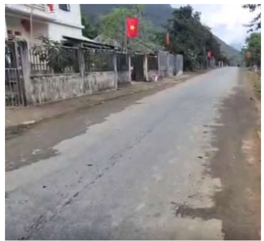
Hình ảnh hiện trạng Km59+200
