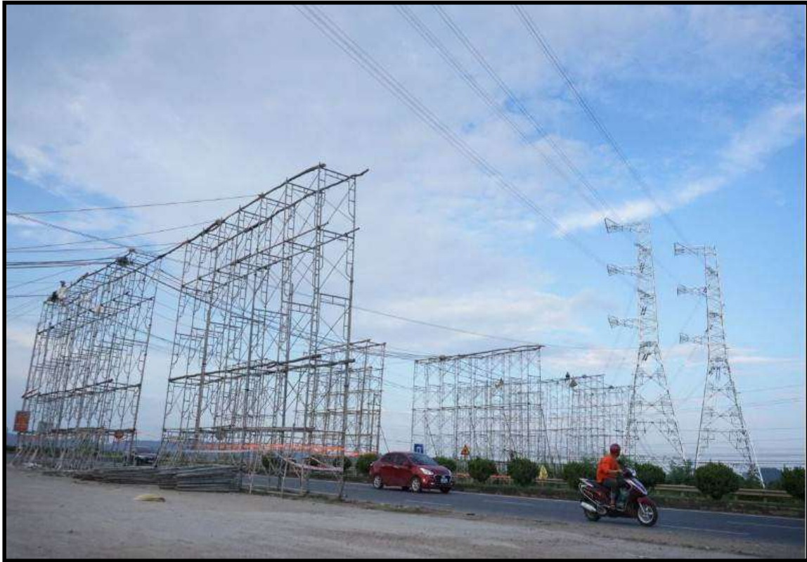
Hình 3.1: Ảnh minh họa lắp giàn giáo phục vụ thi công kéo dây tại vị trí giao chéo với đường giao thông
