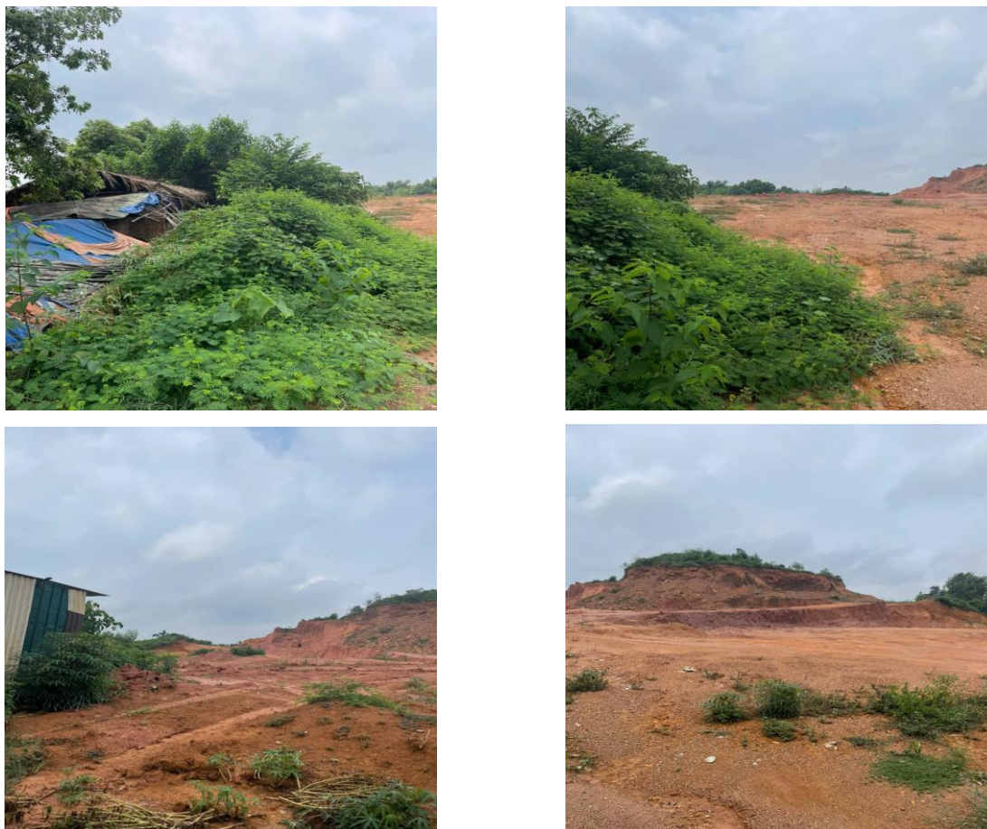
Hình 3.1. Hiện trạng khu đất xây dựng dự án
