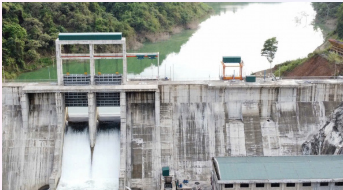
Công trình thủy điện Sông Nhiệm 3 có công suất thiết kế 14,2 MW, khai thác dòng chảy trên Sông Nhiệm (Xã Niêm Sơn, tỉnh Tuyên Quang)
