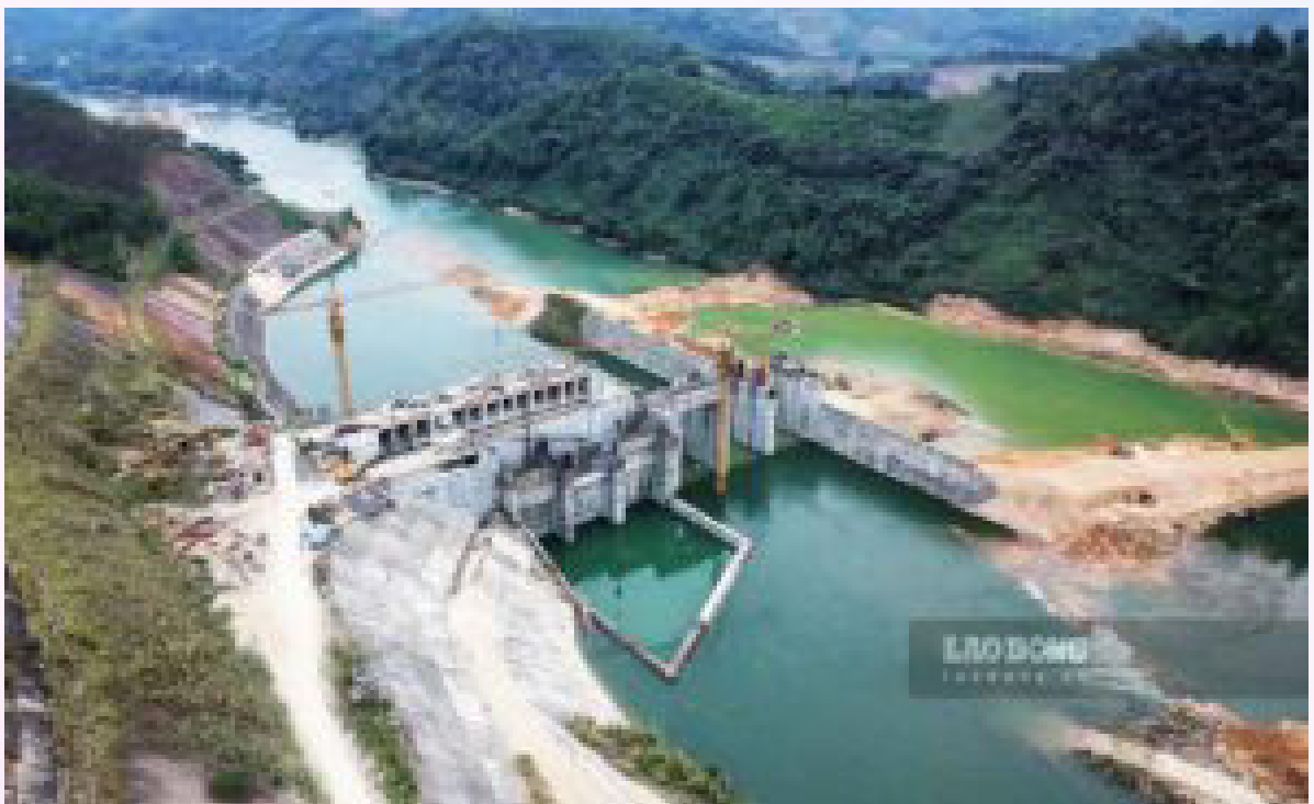
Dự án thủy điện Yên Sơn, xã Lực Hành, tỉnh Tuyên Quang.
