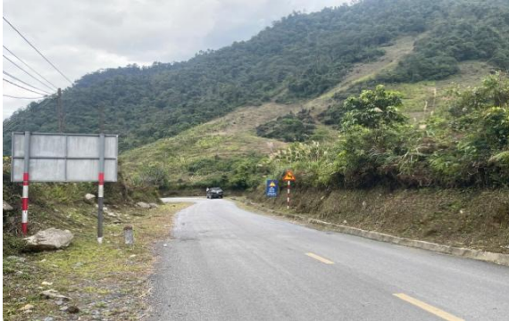
Km 27+500: Đầu tuyến
