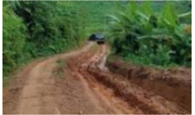
Km 5+500: Đoạn đường đất
