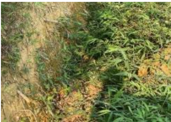
Kênh bị sạt lở, bồi lấp
