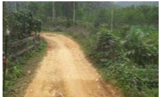
Km7+000: Tuyến đi qua cầu
