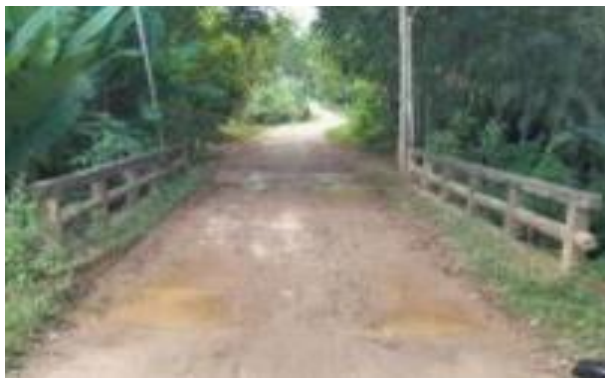
Km2+343,80: Tuyến đi qua cầu
