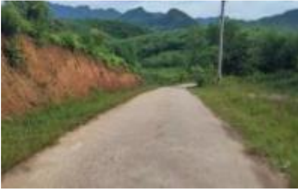
Km4+350: Đoạn đường BTXM bắt đầu từ Điểm giao đầu tuyến tới khoảng
