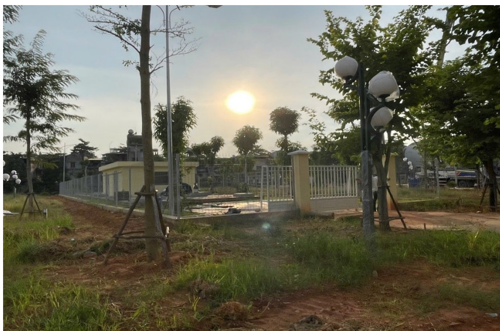
Hình 3.6. Mặt bằng tổng thể trạm xử lý nước thải của dự án
