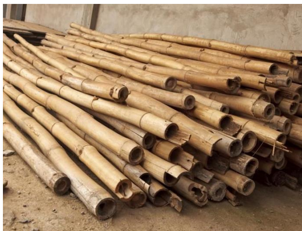
Hình 2. 2. Nguyên vật liệu tập kết tại bãi chứa
