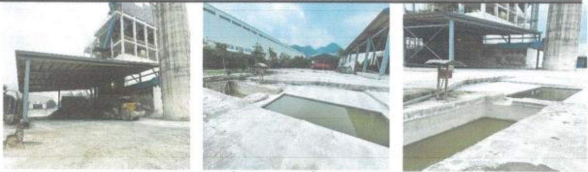
Mái che bãi chứa bùn vôi
