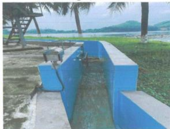
Mương dẫn nước thải chung
