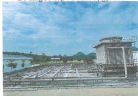
Bể điều hòa
