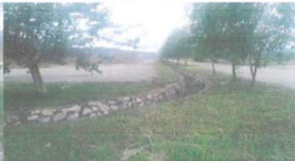
Mương thu nước mưa bãi chứa nguyên liệu
