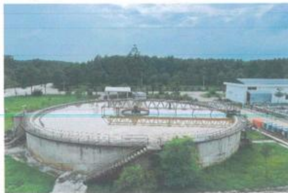
Bể lắng sơ cấp và thiết bị gạt bùn
