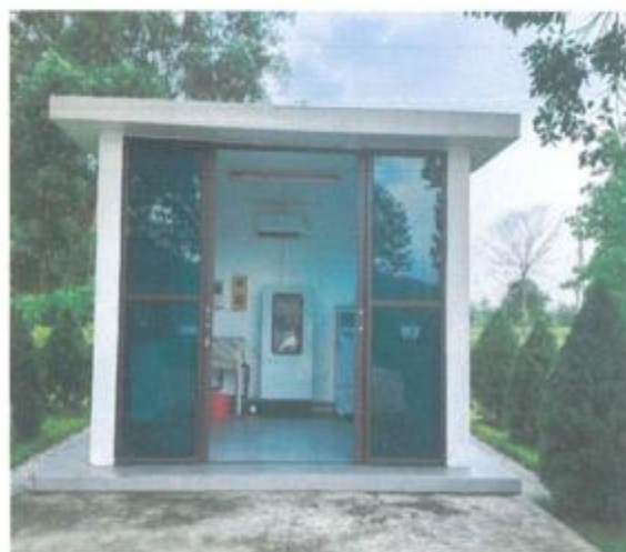
Trạm quan trắc tự động nước thải
