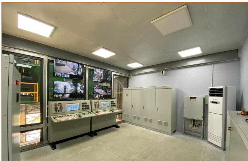
Phòng điều khiển vận hành lò đốt
