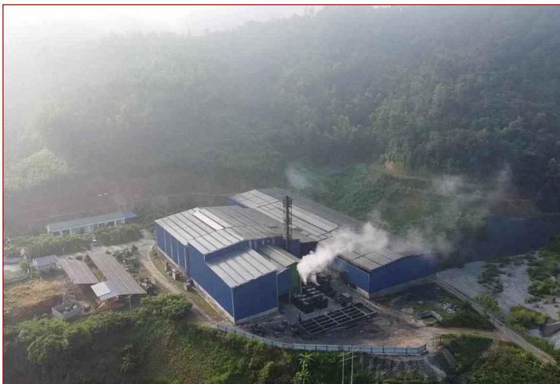
Lò đốt rác sinh hoạt RS-Vinabima công suất đốt 3000kg/giờ tại xã Pom Lót, huyện Điện Biên, tỉnh Điện Biên.
