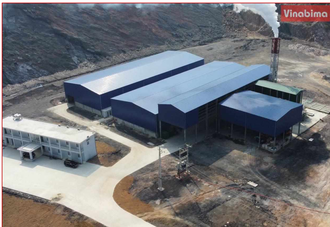
Lò đốt rác sinh hoạt RS-Vinabima công suất đốt 4000kg/giờ lắp tại xã Tràng Lương, thị xã Đông Triều, tỉnh Quảng Ninh.
