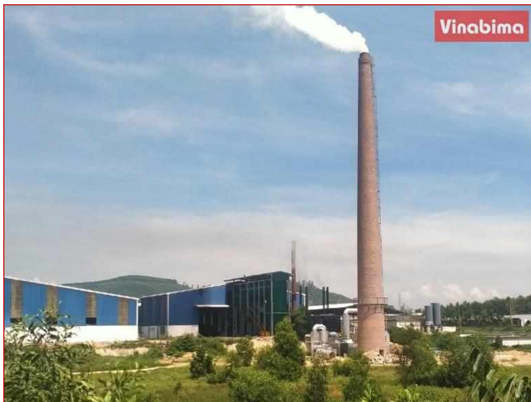
Lò đốt rác sinh hoạt RS-Vinabima công suất đốt 3000kg/giờ tại nhà máy xử lý rác thải Nghĩa Kỳ, tỉnh Quảng Ngãi.
