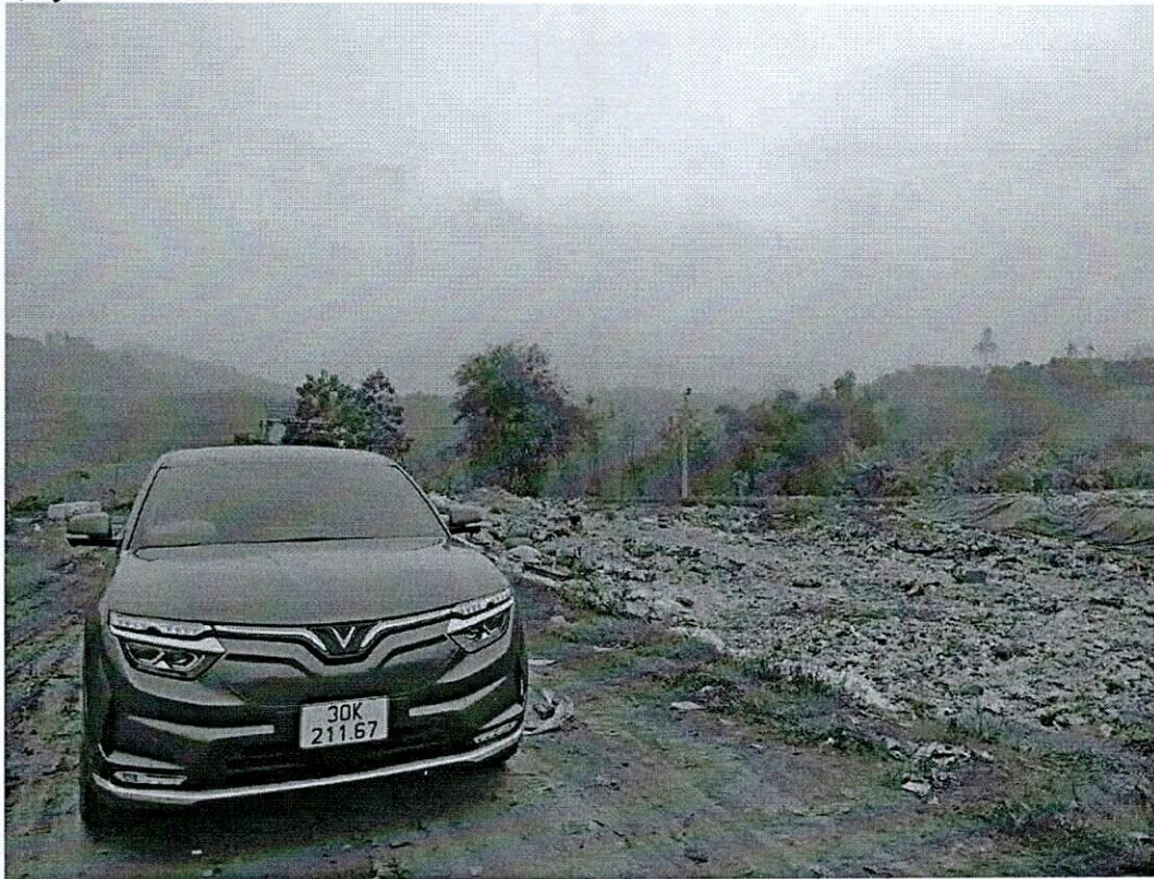
Hình 4. Hệ thống đường giao thông nội bộ chưa được cứng hóa, mương thoát nước là mương đất
