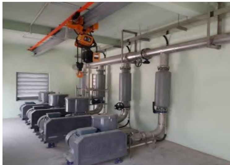
Hình 11. Máy thổi khí
