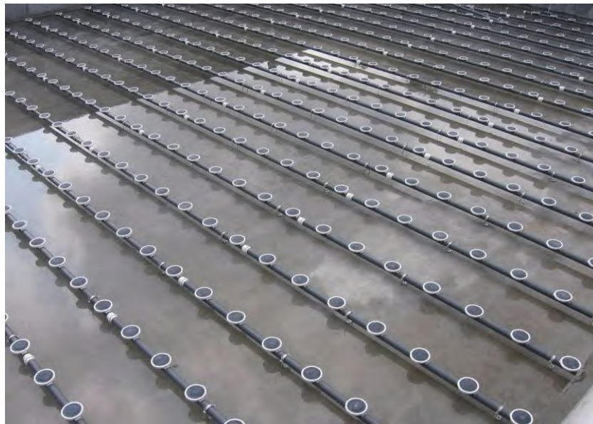
Hình 10. Hệ thống phân phối khí tinh
